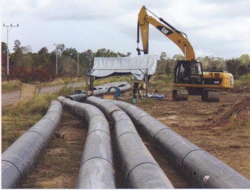
Proyek SDA Perpipaian Air Baku Sungai Maro Merauke, Papua
